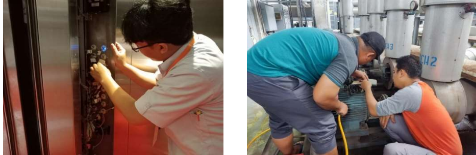
Gambar 15. Pemeliharaan Lift dan AC Sentral Gedung Basarnas
